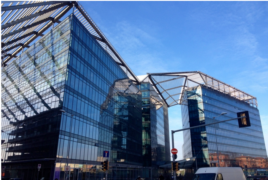
Fig.37 – La nuova sede del Comune di Bologna
