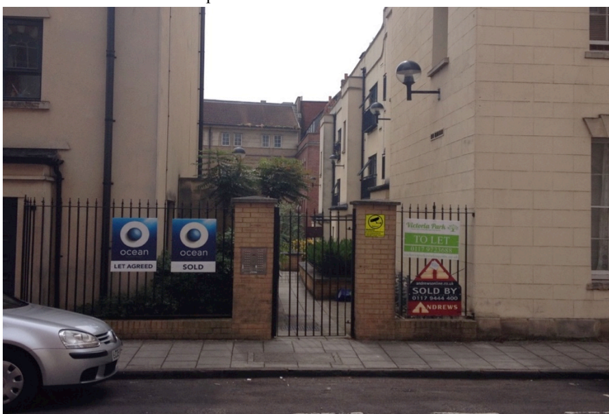
Fig.67 – Immobile condominiale recentemente ristrutturato in cui si rinviene il rifacimento della cancellata, l'inserimento di una nuova illuminazione e la presenza di telecamere di sicurezza
