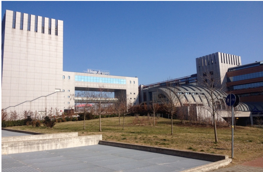
Fig.34 – Porta Europa. Complesso direzionale del gruppo Unipol recentemente costruito nella zona Est della Bolognina
