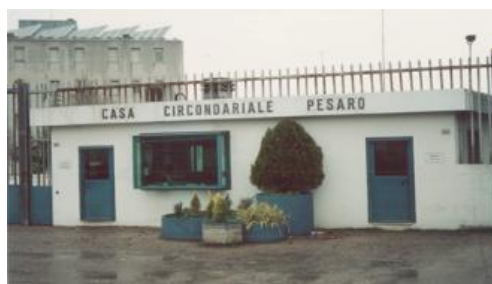
Villa Fastiggi – Pesaro, Ingresso Casa Circondariale
