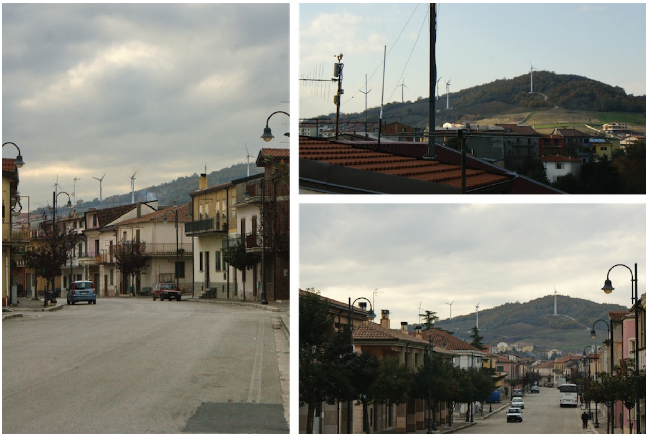
Figura 6.2. AQUILONIA: le recenti installazioni di minieolico, da tre diverse angolazioni (foto: Valerio Coppola 2015).
