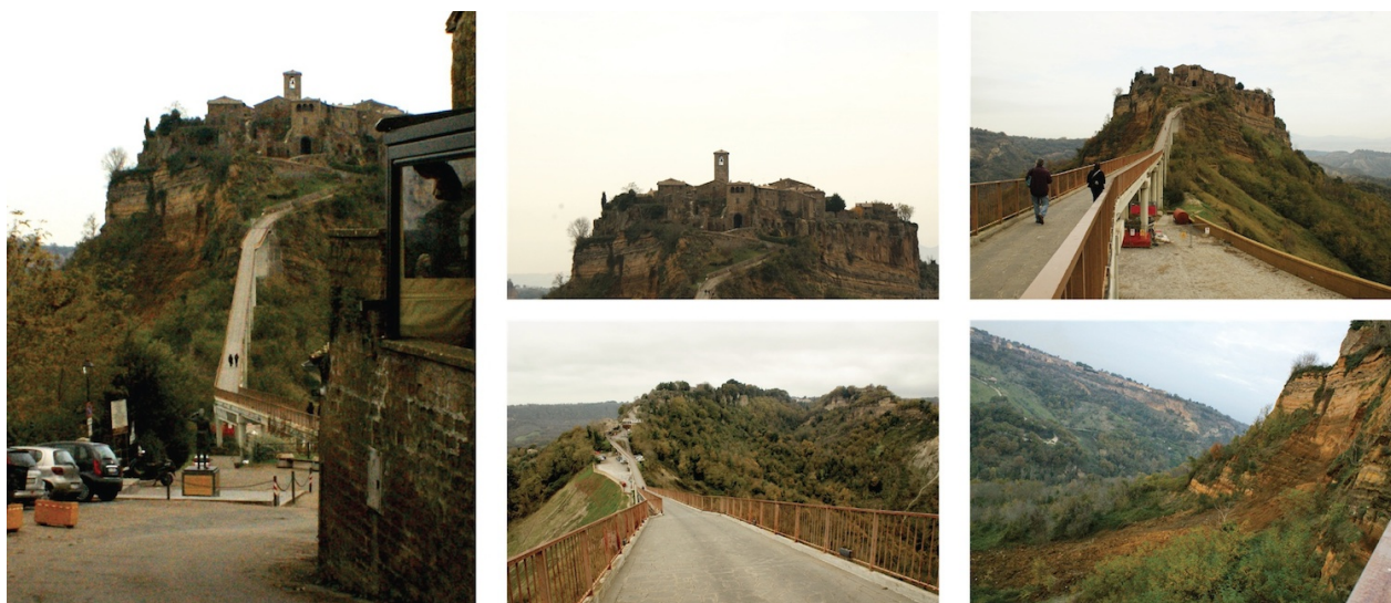
Figura 5.15.a. CIVITA DI BAGNOREGIO: vista dall'esterno e ponte. Nella prima e (in dettaglio) nell'ultima foto, alla sinistra del ponte, una frana verificatasi nei giorni precedenti la mia visita, sulla parete nord-ovest del poggio (foto: Valerio Coppola 2014).
