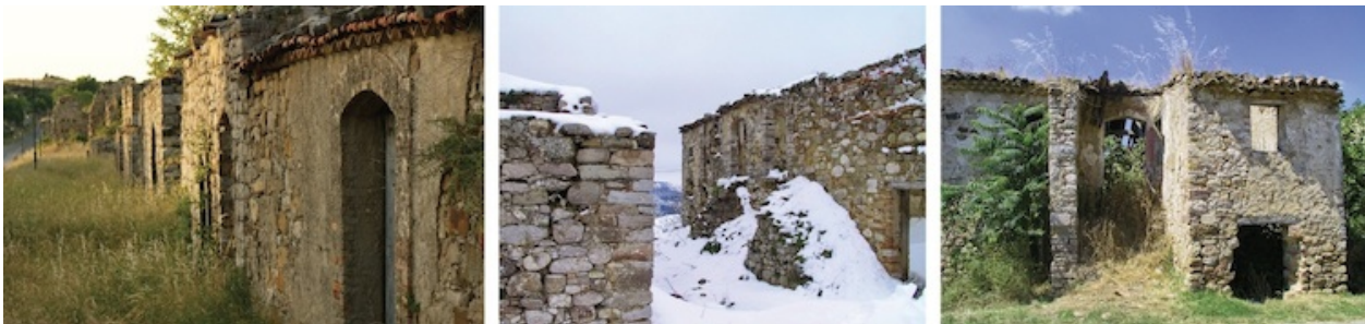
Figura 5.9. AQUILONIA: scorci del vecchio abitato di Carbonara/Aquilonia, nella parte non interessata dalla discarica, e ancora oggi non recuperata (foto: Valerio Coppola 2012; Emiliano Coppola 2003, 2004). Questa parte si è comunque mantenuta "più integra" di quella poi diventata Parco Archeologico, pressoché livellata nel corso dei decenni.
