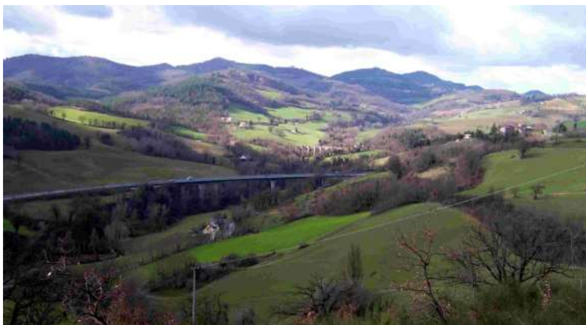
Fig. 2.1 - la vallata principale del bacino del fosso Santa Maria degli Angeli visto da Est (foto 12/02/2014). Si nota il tratto di strada chiamato “Bretella” e il ponte della vecchia ferrovia in secondo piano.
